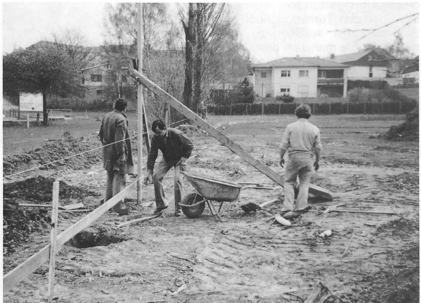
Drei neue Tennisplätze kommen hinzu: Bei der Arbeit von links: Steiner, Haidinger, Giegler und mit dem Rücken zur Kamera Preineßl.
