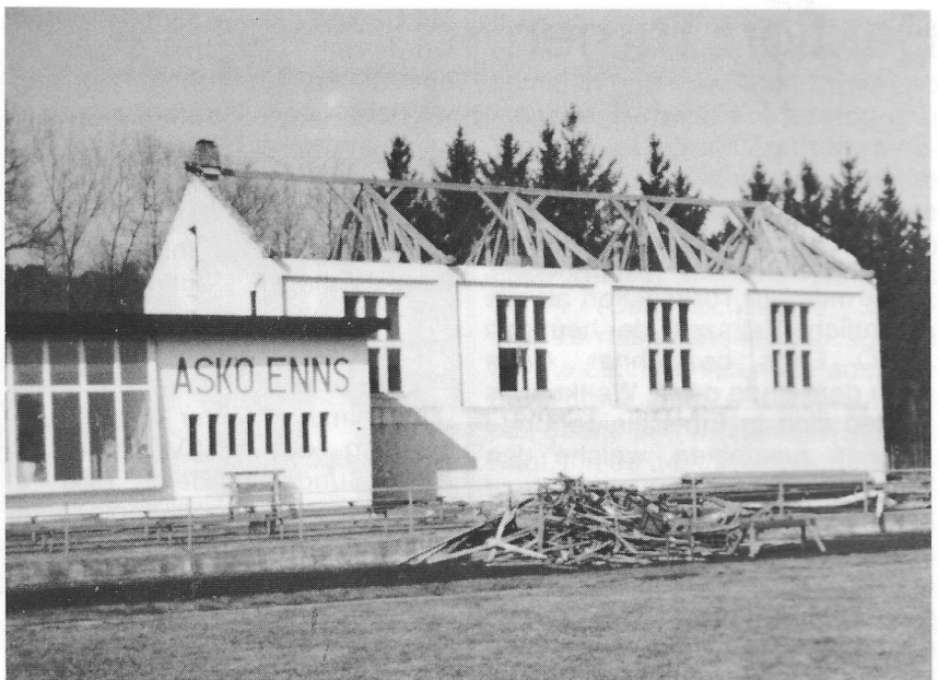
1982: Die Turnhalle hat ausgedient, sie muß dem Neubau weichen.
